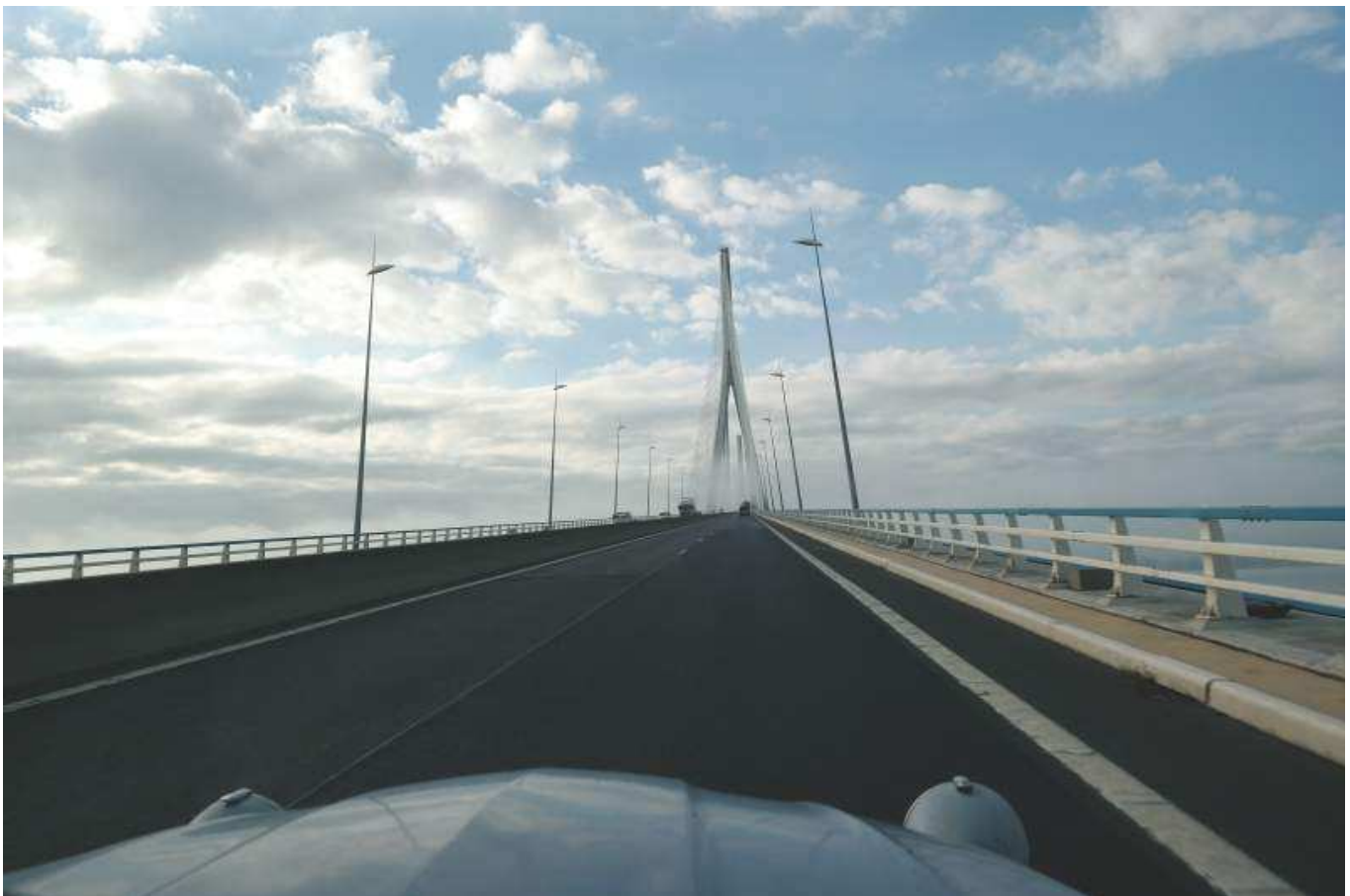
Pont de Normandie
